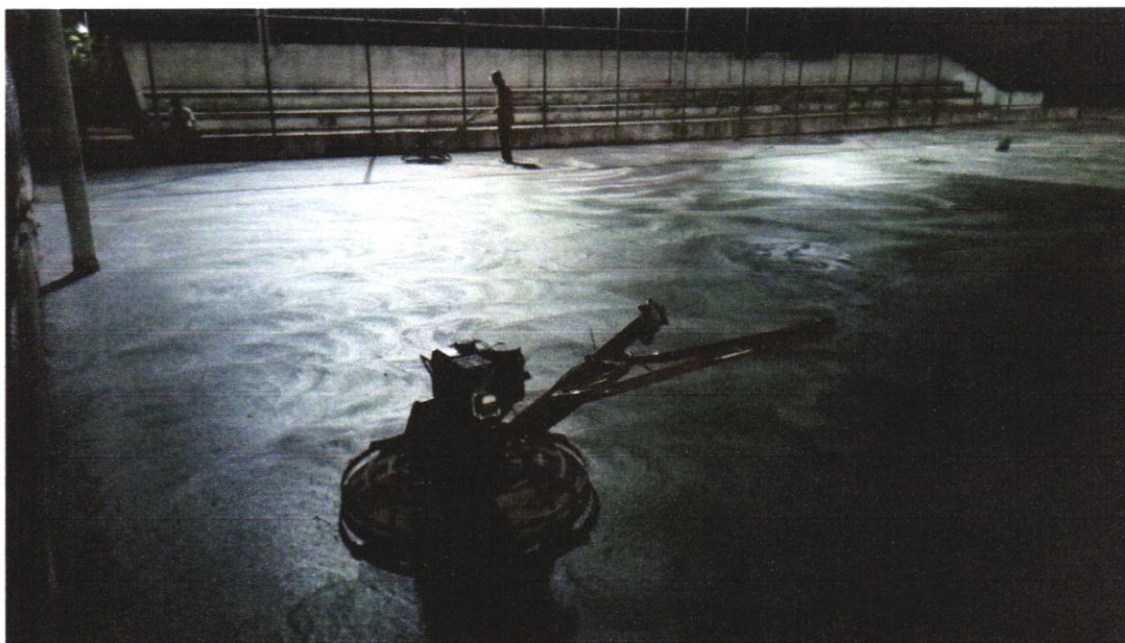
Foto 07 - ACABAMENTO POLIDO PARA PISO DE CONCRETO ARMADO DE ALTA RESISTÊNCIA. AF_09/2017
