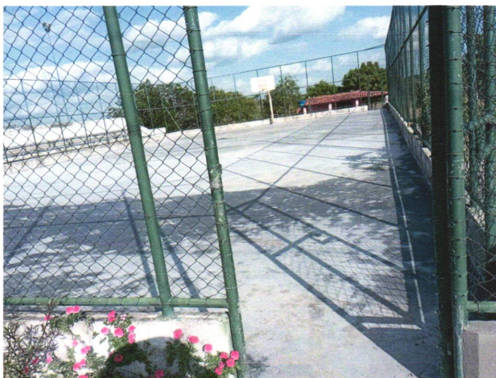
Foto 08 – ALAMBRADO PARA QUADRA POLIESPORTIVA, ESTRUTURADO POR TUBOS DE AÇO GALVANIZADO, (MONTANTES COM DIÂMETRO 2", TRAVESSAS E ESCORAS COM DIÂMETRO 1 ¼ ), COM TELA DE ARAME GALVANIZADO, FIO 10 BWG E MALHA QUADRADA 5X5CM (EXCETO MURETA). AF_03/2021
