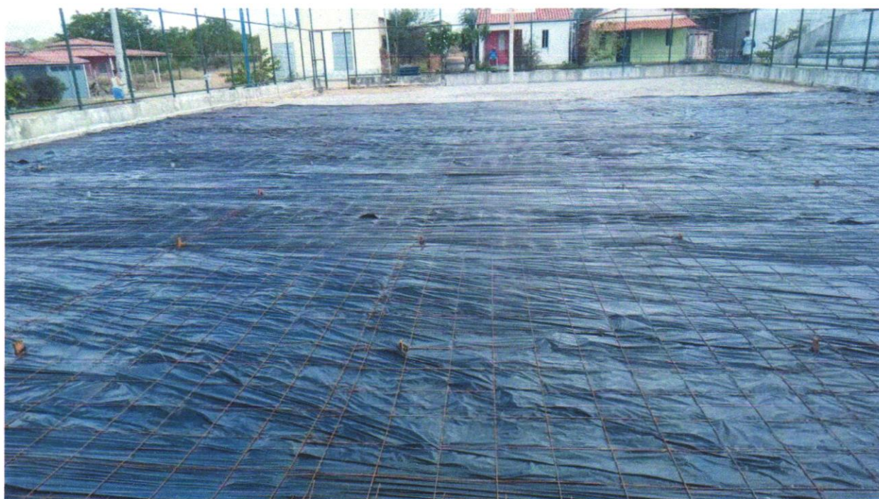
Foto 04- APLICAÇÃO DE LONA PLÁSTICA PARA EXECUÇÃO DE PAVIMENTOS DE CONCRETO. AF_11/2017
