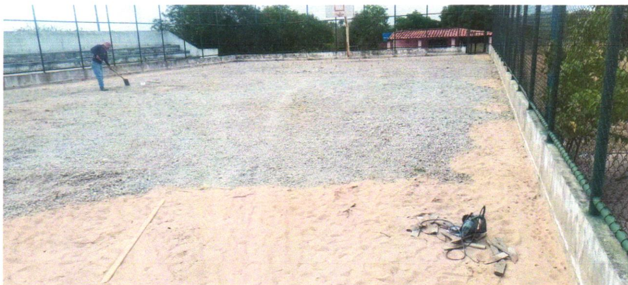
Foto 03 – LASTRO DE BRITA GRADUADA APLILOADA E=10CM
